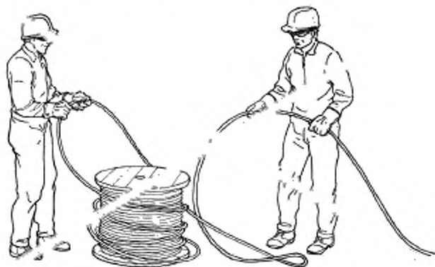
в) Разматывание каната с бобины
